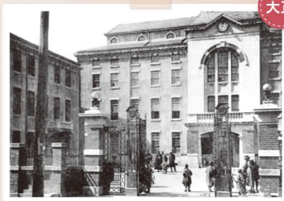
大正9年に建築された三崎町校舎
